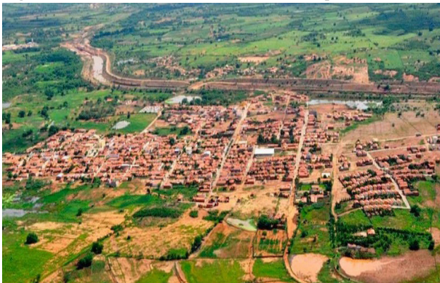
Figura 2 – Sede de Penaforte e o canal da transposição
