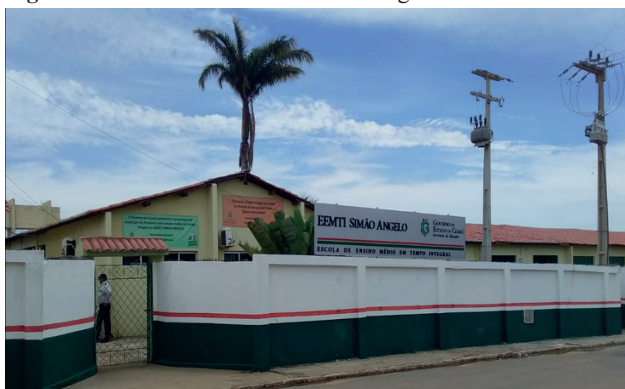
Figura 4 – Fachada da Escola Simão Ângelo
